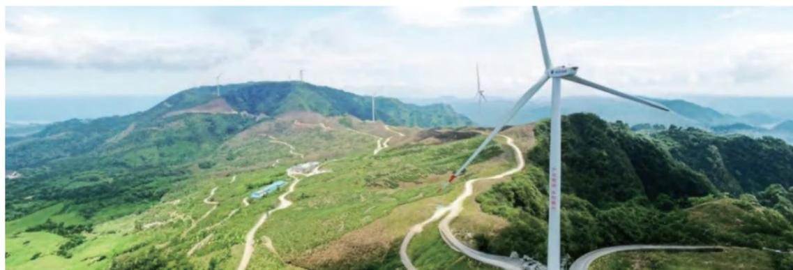
在梅山港区的绿色港口项目中，针对沿海复杂环境，运达股份运用中压双馈6.25兆瓦风电机组，特别定制了防盐雾、超大风轮控制等技术，有效应对气流不均衡导致的疲劳载荷问题，不仅延长了机组使用寿命，还使得发电效率提升2%。据测算，一台机组日均发电量月3万千瓦时，全容量并网后，每年可为港区提供月5917万千瓦时清洁能源，节省约520万元能耗费用，减少约2.26万吨二氧化碳排放，在助力港口绿色转型的同时，也为周边乡村带来了经济和环境效益。
